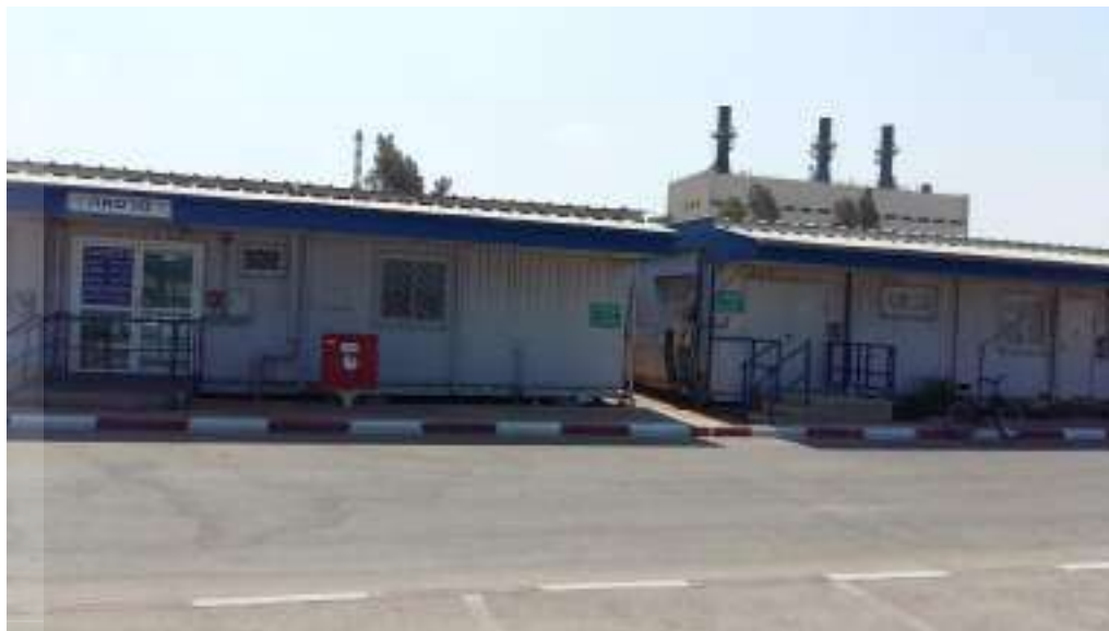
איור מס' 21: שטח חניה, מבני שירות (כגון מרפאה) ומבנה אשכול א' ברקע.
