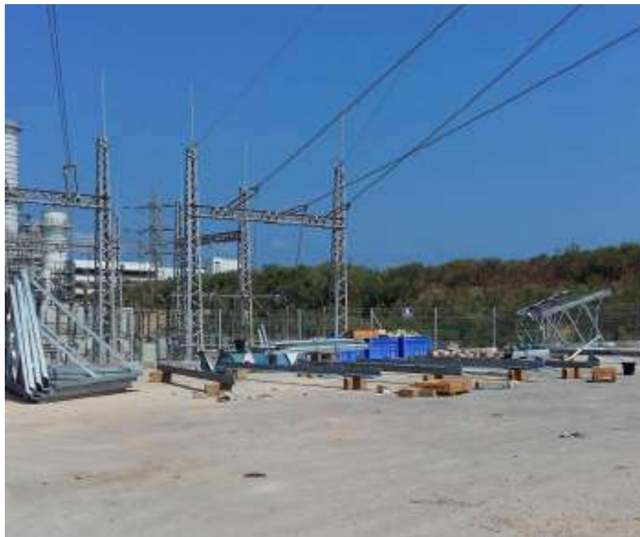
איור מס' 26: מתחם אחסון ברזלים ומסדר הוצאת אנרגיה ברקע
