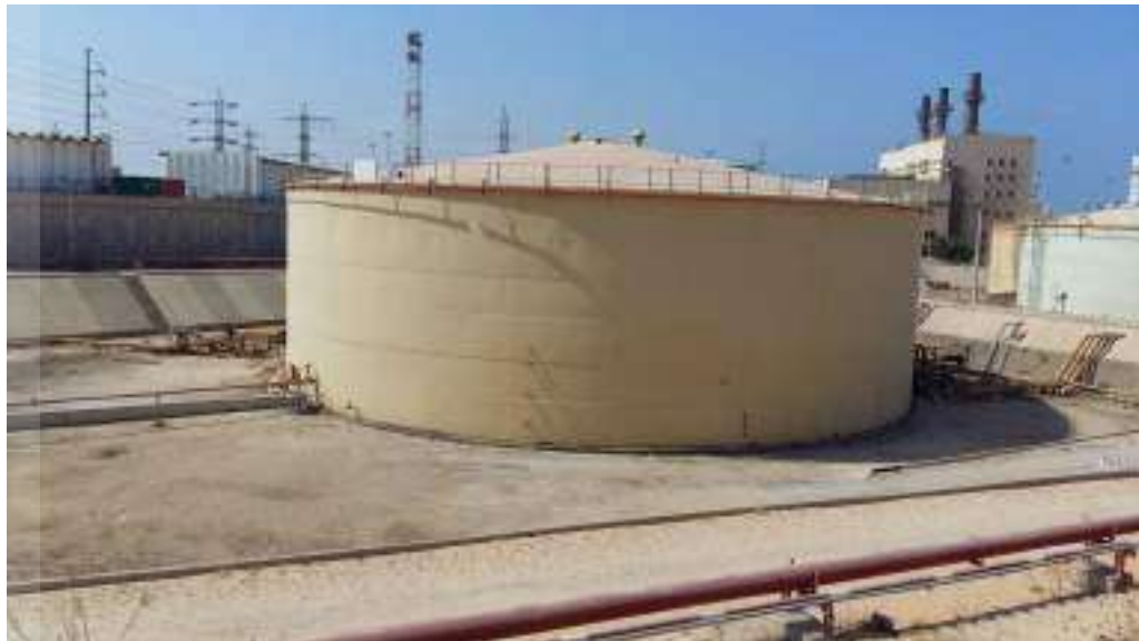
איור מס' 20: אתר דלק 3 – אחסון סולר
